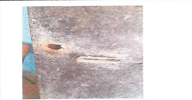
Foto 6: Mantenimiento de puerta y e instalación de chapa nueva.
